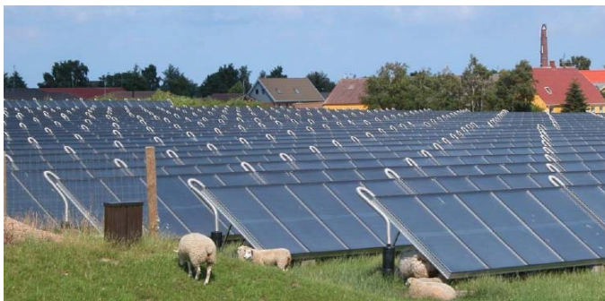
Колекторно поле на слънчева топлофикация към малко градче в Дания
