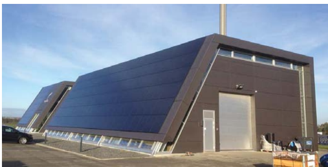
Ново поколение градска топлоцентрала. Фасадата е облечена с фотоволтаични панели, покриващи нуждите на циркулационните помпи
